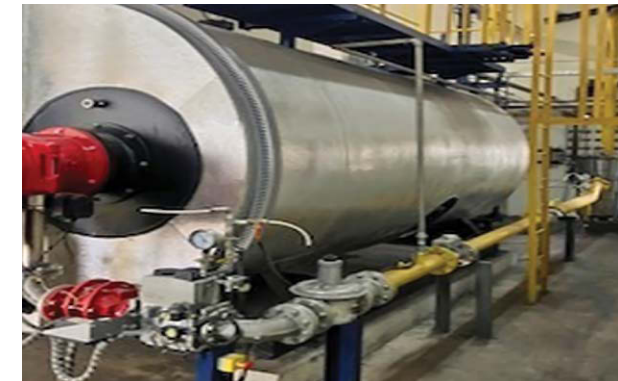
Biogas Boiler (Subang, Indonesia)
